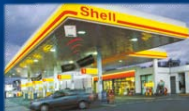
Carga de Combustible Fuel Loading
